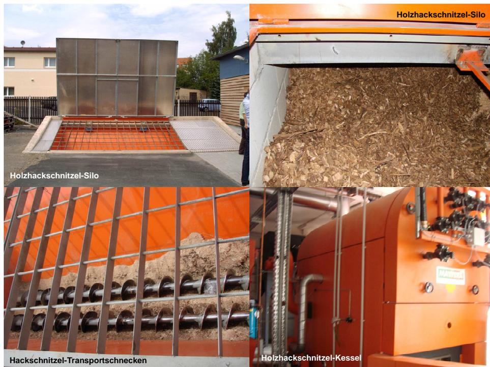
Abb. 3.4.4.1-2: Holzhackschnitzel-Heizwerk Grimma-West;  $P_{Nth} = 700 \text{ kW}$
