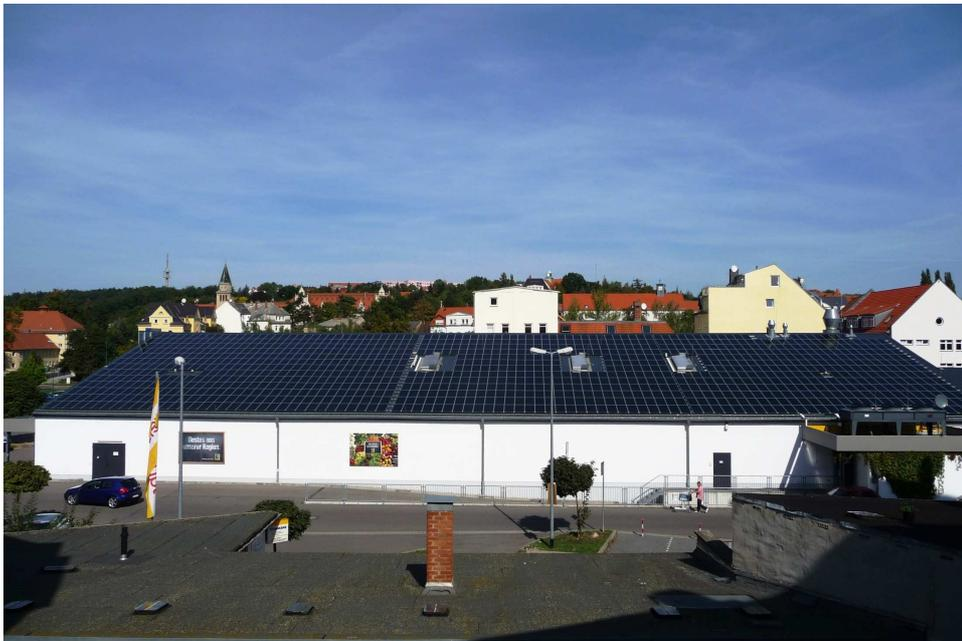
Abb. 3.3.3.6-1: PV-Dachanlage Edeka-Markt Döbeln – CdTe-Module/FirstSolar - P<sub>ges</sub> = 85,5 kW<sub>p</sub>
