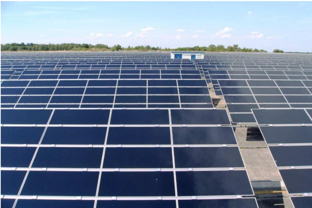
Abb. 3.3-3: PV-Kraftwerk „Waldpolenz“ (LK. Leipzig); P = 40 MW<sub>p</sub>; CdTe-Module (Ausschnitt)
