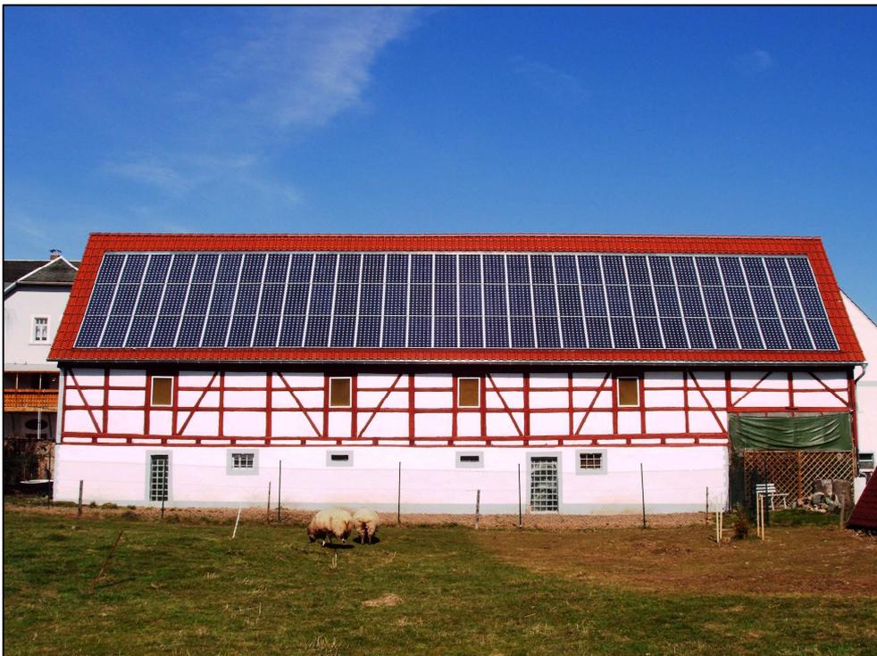
Abb. 3.2-12: PV-Dachanlage Grunau (Lkr. Mittelsachsen);  $P = 15,75 \text{ kW}_p$
