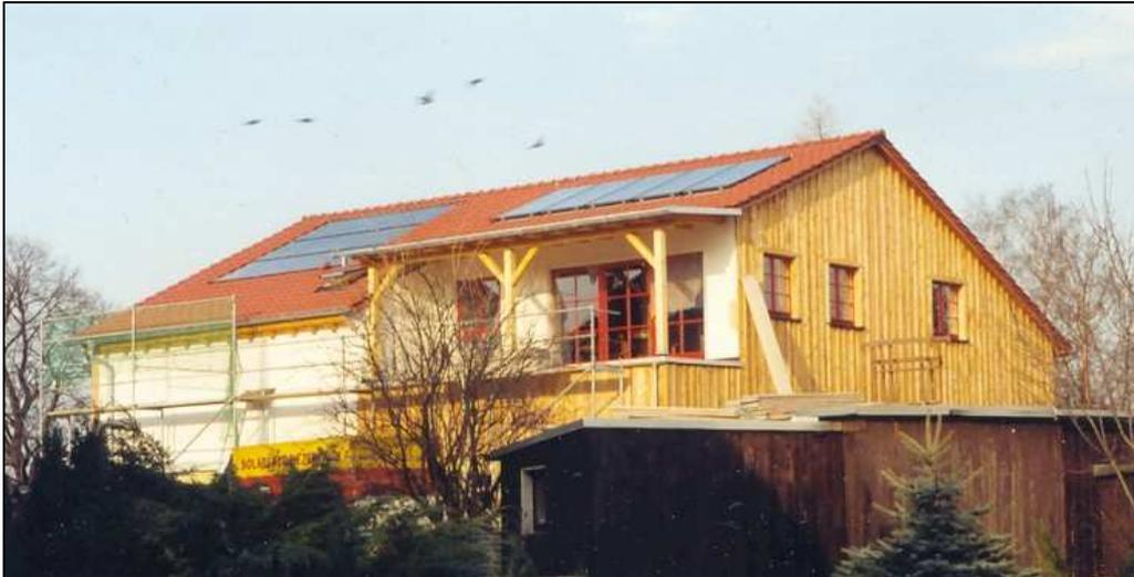
Abb. 3.2-19: Solarergiezentrum Oberseifersdorf (GR); linke Seite PV-Module 1,89 kW<sub>p</sub>, rechte Seite: Solarthermie-Kollektoren
