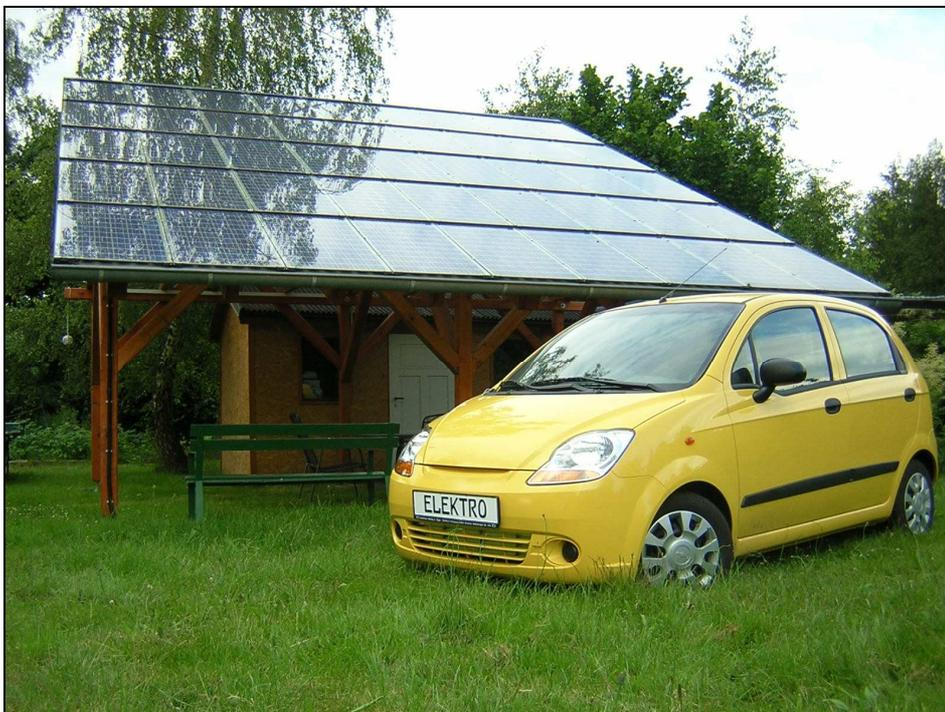
Abb. 3.2-23: PV-Tankstelle für Elektrofahrzeuge,  $P = 4 \text{ kW}_p$
