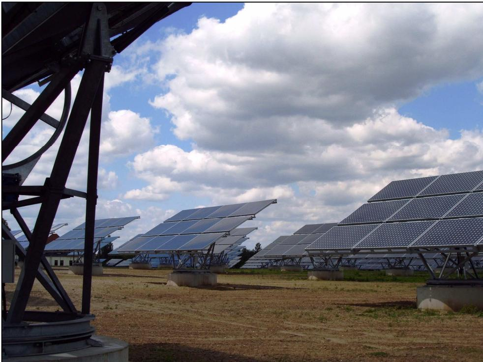
Abb. 3.2-10: PV-KW „Borna-West“ (L) –  $P = 3,44 \text{ MW}_p$  – Zweifache Modulnachführung
