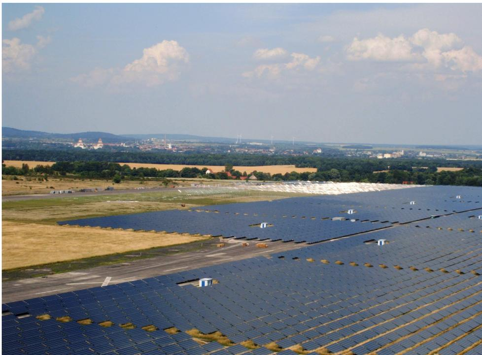
Abb. 3.2-8: PV-KW „Waldpolenz“ (Lkr. Leipzig)  $P = 40 \text{ MW}_p$ , davon  $24 \text{ MW}_p$  am Netz
