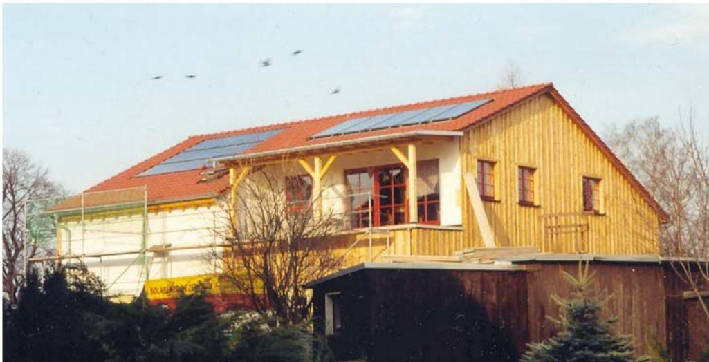
Abb. 3.2-19: Solarergiezentrum Oberseifersdorf (GR); linke Seite PV-Module 1,89 kW<sub>p</sub>, rechte Seite: Solarthermie-Kollektoren; Quelle: Foto, Blochberger
