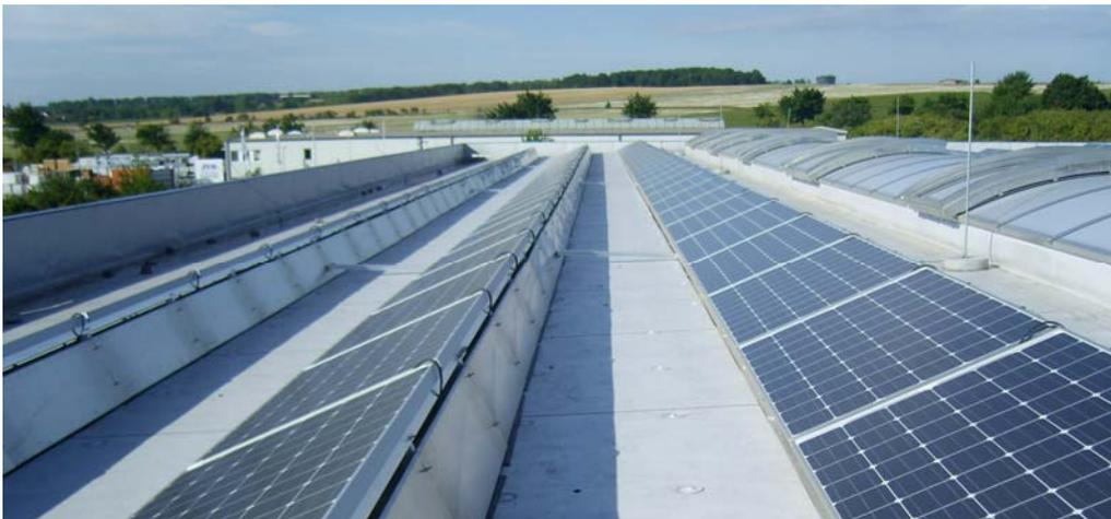
Abb. 3.2-21: Industriedach mit PV-Modulen
