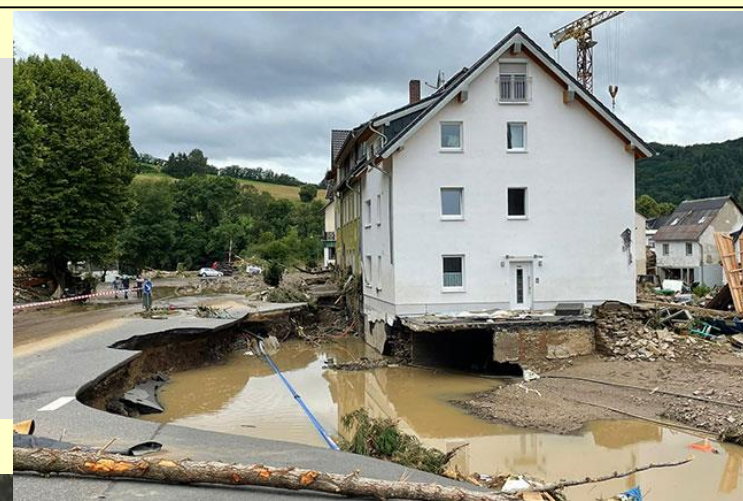
Zerrissene Straßen und einsturzge- fährdete Häuser
